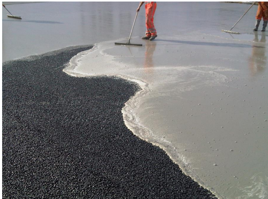
Aanbrengen cementslurry in de zeer open asfaltbeton
